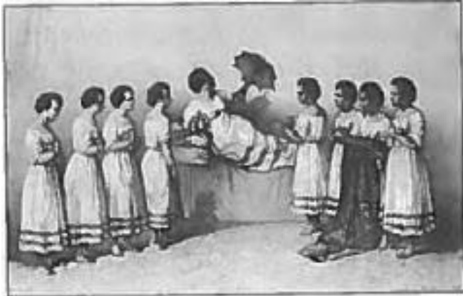
የንጉሥ ሣህለሥላሴ ባለቤት ወይዘሮ በዛብሽ የፈረንሳይ መልእክተኛ ሮሼ ደሐሪኩ የሰጡባቸውን ጃንጥላ ዘርግተው ከደንገጡ ሮቻቸው ጋር ሆነው ሲመለከቱ
