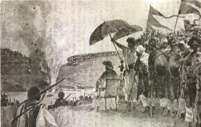
ምኒልክ ቋጥኞችን በድማሚት እያስፈረሱ መንገድ ሲያሠሩ ።
